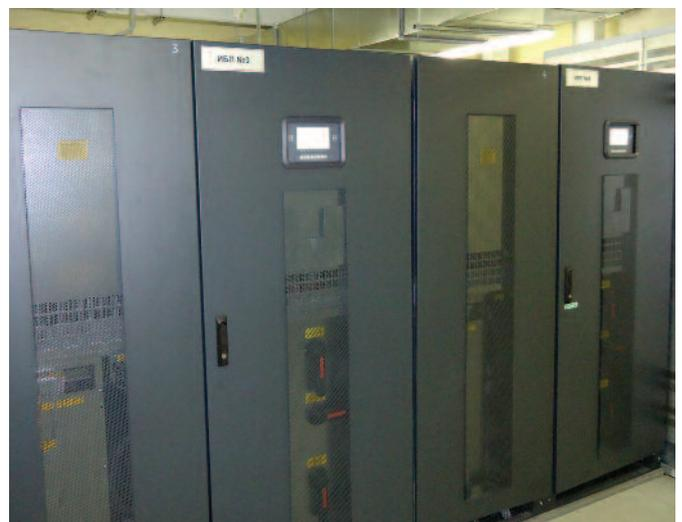
На иллюстрации - ИБП ENTEL HPX 400 кВА, установленные в параллель в одном из дата-центров.
