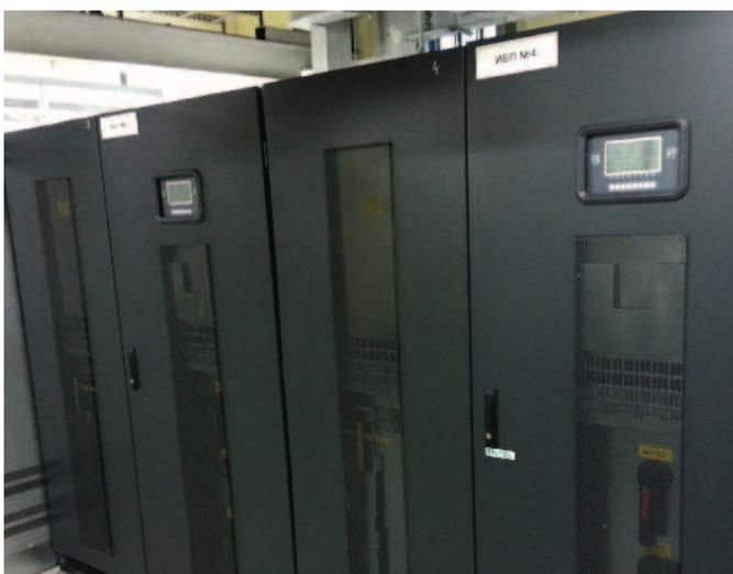
На иллюстрации - ИБП ENTEL серии МРХ общей мощностью 1,6 МВА, установленные в одном из крупнейших коммерческих дата-центров г.Москвы.
