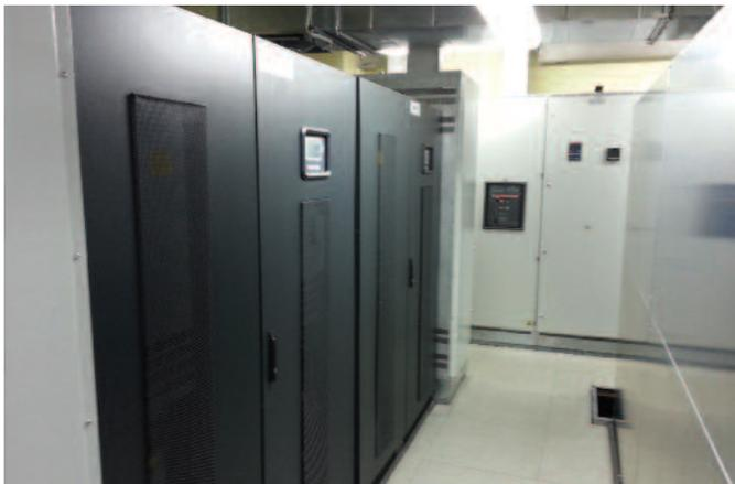
Четыре ИБП ENTEL серии NPX общей мощностью 1,6 МВА установлены в одном из крупнейших коммерческих дата-центров г.Москвы
