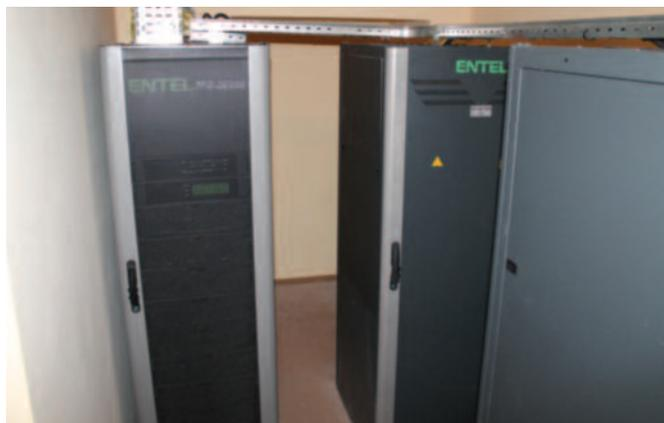
Модульные ИБП ENTEL серии IPS мощностью 200 кВА, установленные по схеме N+2 защищают сеть питания городской больницы одного из крупных городов Подмосковья.
