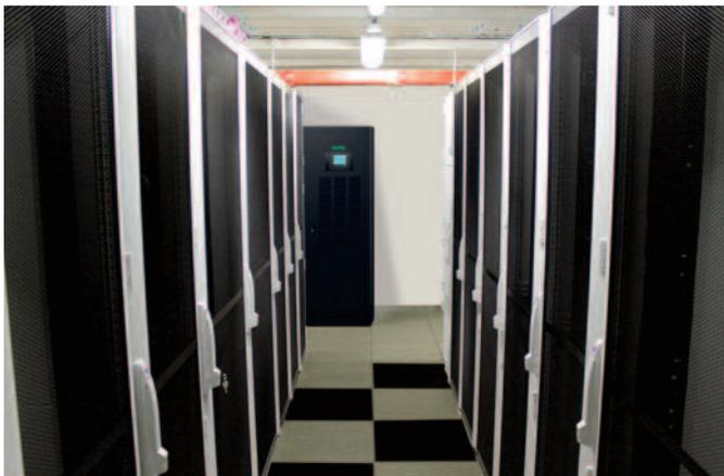
Система бесперебойного питания для ЦОД одной из государственных организаций. Шесть моноблочных ИБП ENTEL по 100 кВА - схема N+1.
