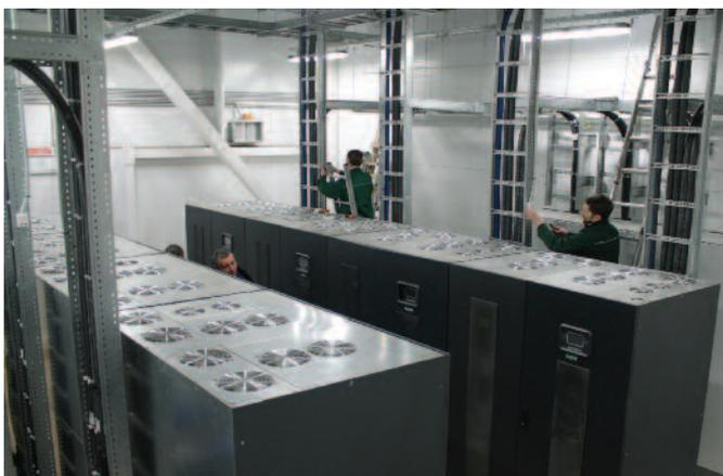
Система бесперебойного питания для ЦОД крупной телекоммуникационной компании состоит из восьми ИБП ENTEL мощностью по 400 кВА каждый. КПД системы в Эко-режиме достигает 99%.
